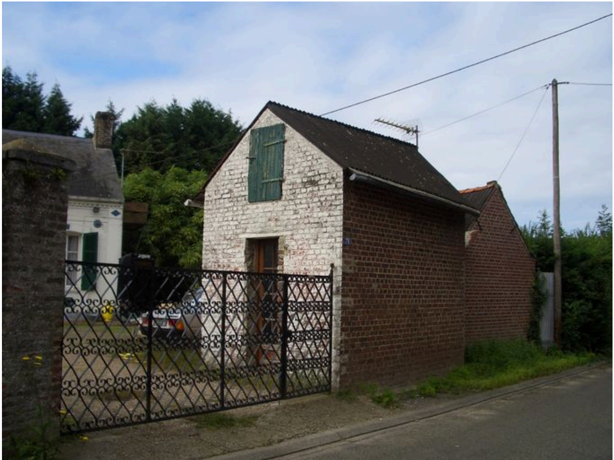
Portail d'entrée et petit logement sur rue.
