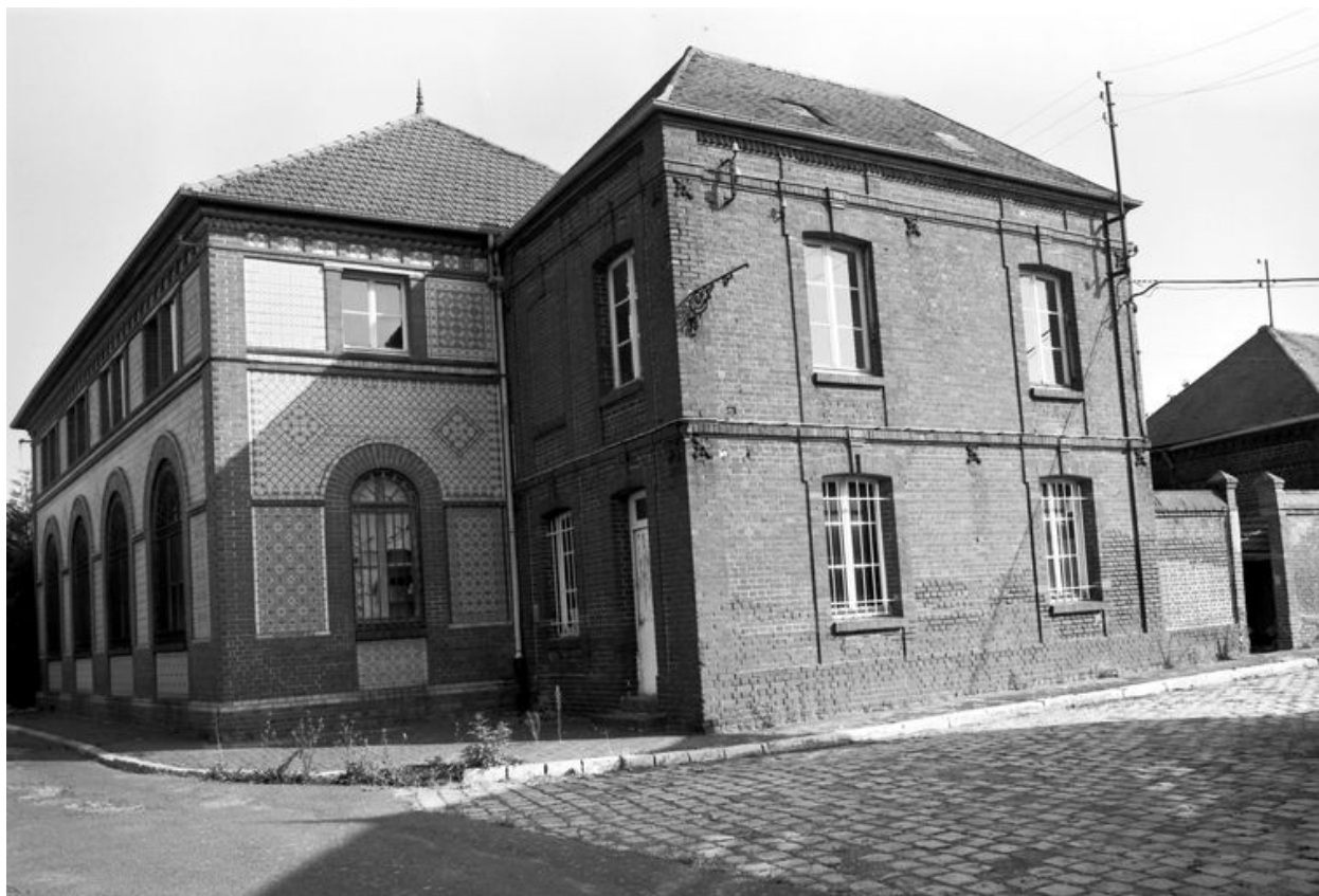
Mur sud du bureau.
