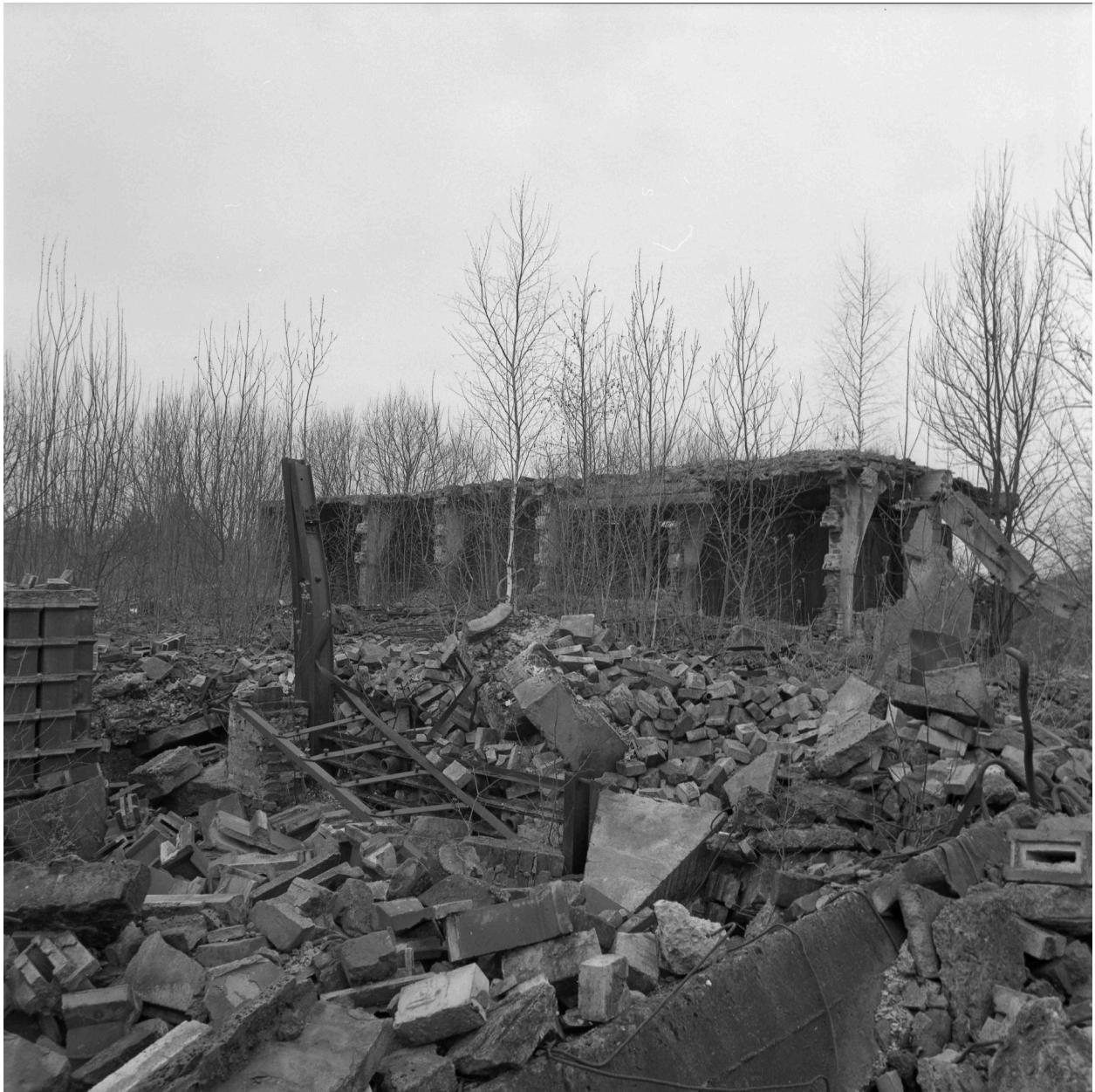
Vestiges du four de cuisson, état en 1996.
