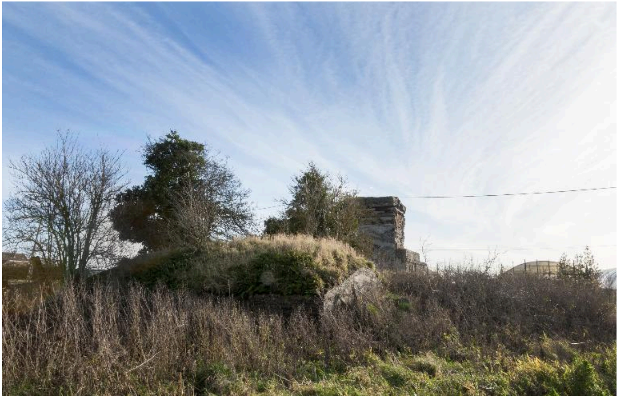
Vue vers le sud-est. Au premier plan l'avant de la casemate c.
