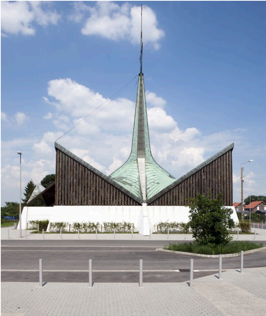
Vue générale de l'élévation sud.
