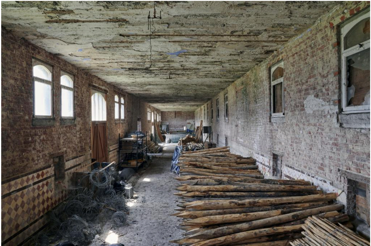
Intérieur des anciennes grandes étables, vue vers l'est.
