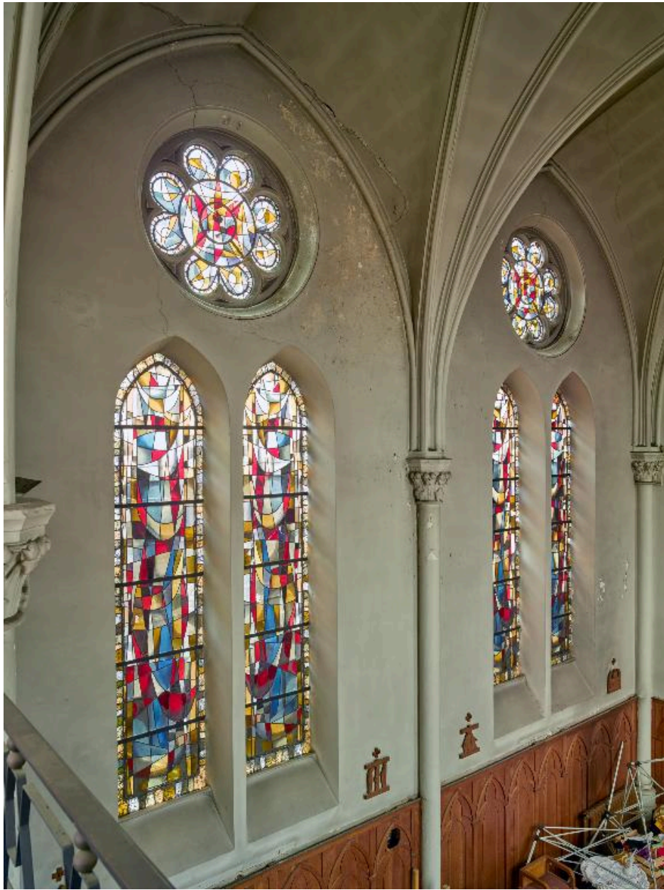
Verrières nord du chœur
