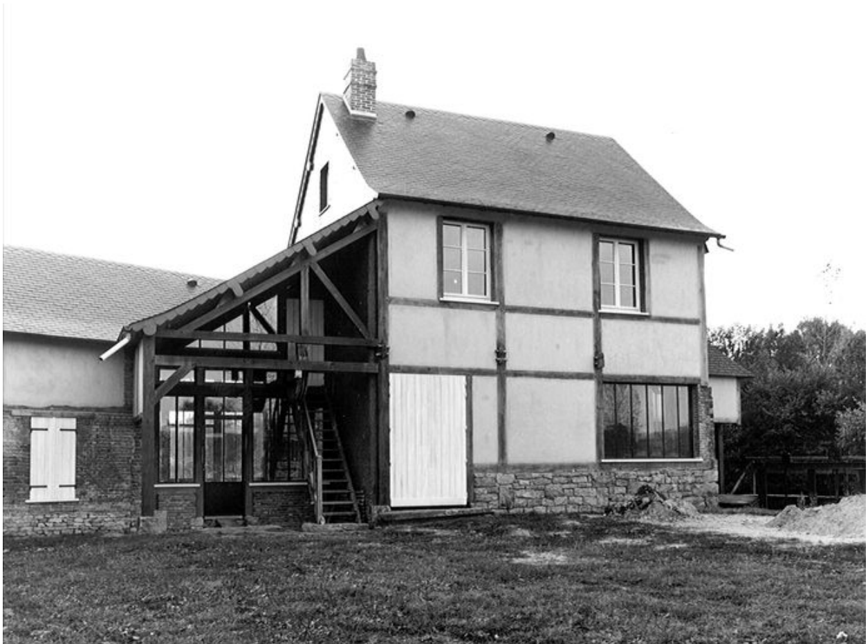
Façade ouest de l'atelier de fabrication.
