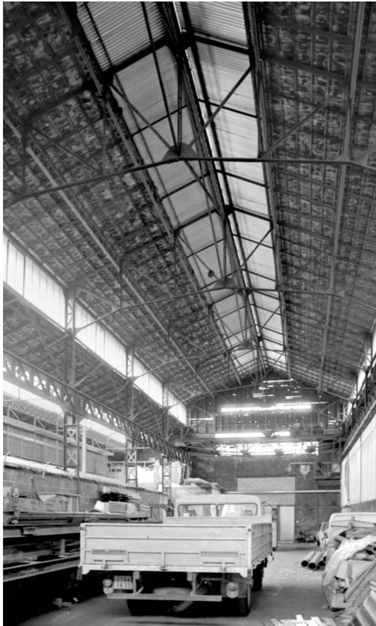
Atelier de fabrication : vue intérieure.
