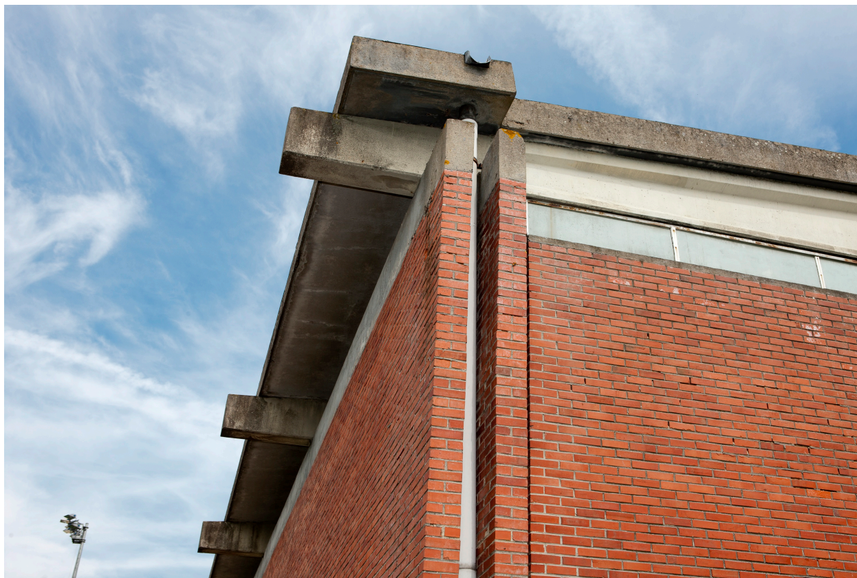
Gymnase de 1969 : détail de la partie extérieure du couvrement et de la couverture, 2016.
