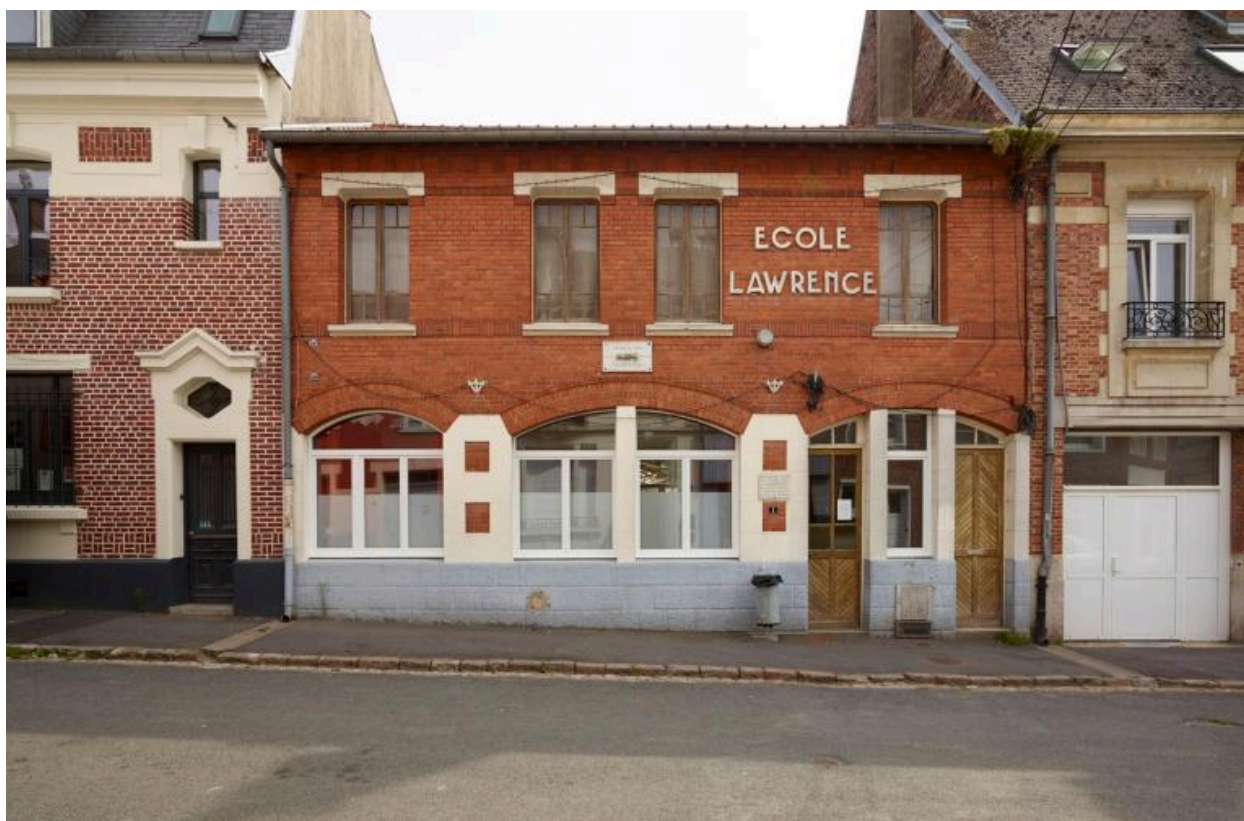
Ecole lawrence, rue Jean-Baptiste-Lequette. Construite en 1939.
