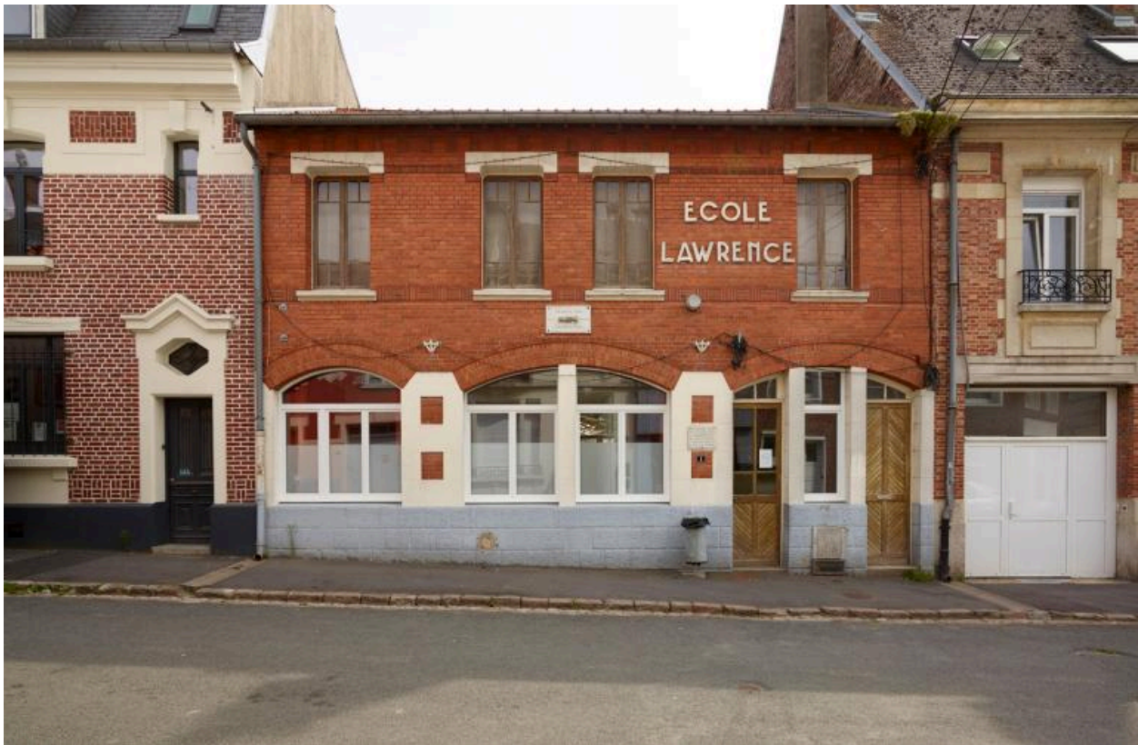
Ecole lawrence, rue Jean-Baptiste-Lequette. Construite en 1939.
