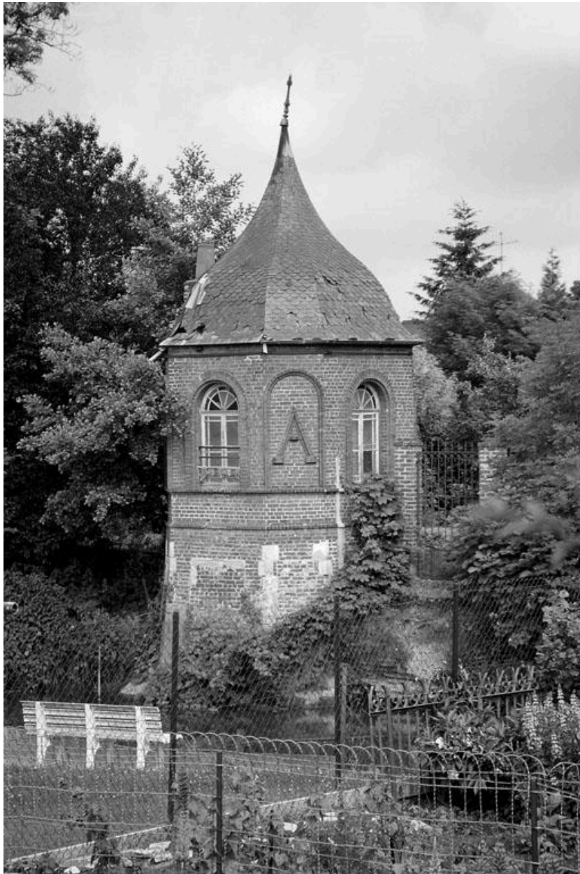
Vue du pavillon, construit au fond du jardin, au bord de l'Oise.
