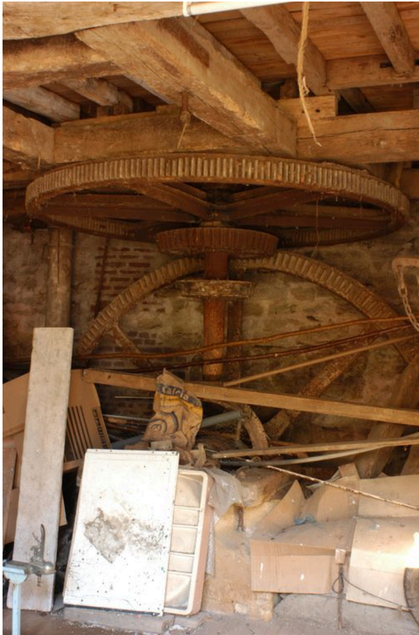
Le beffroi et les mécanismes de transmission du moulin.
