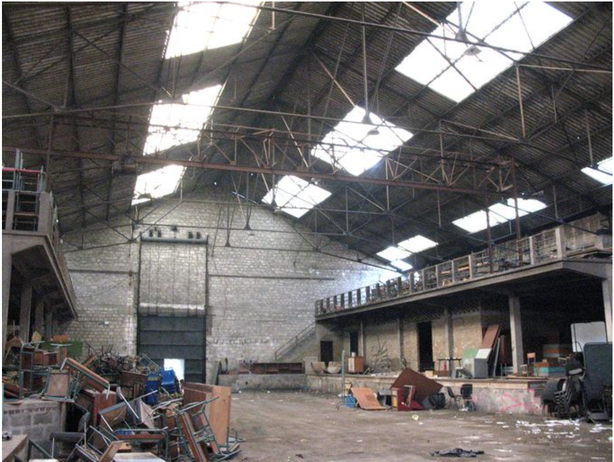
Vue intérieure de la halle principale.
