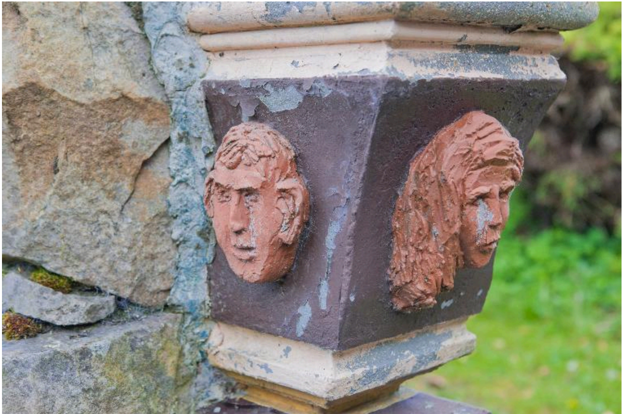
Détail de chapiteau.
