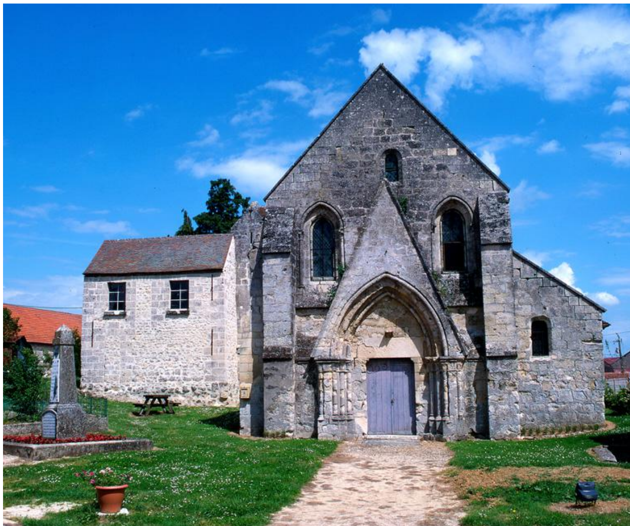
Vue extérieure de la façade occidentale.
