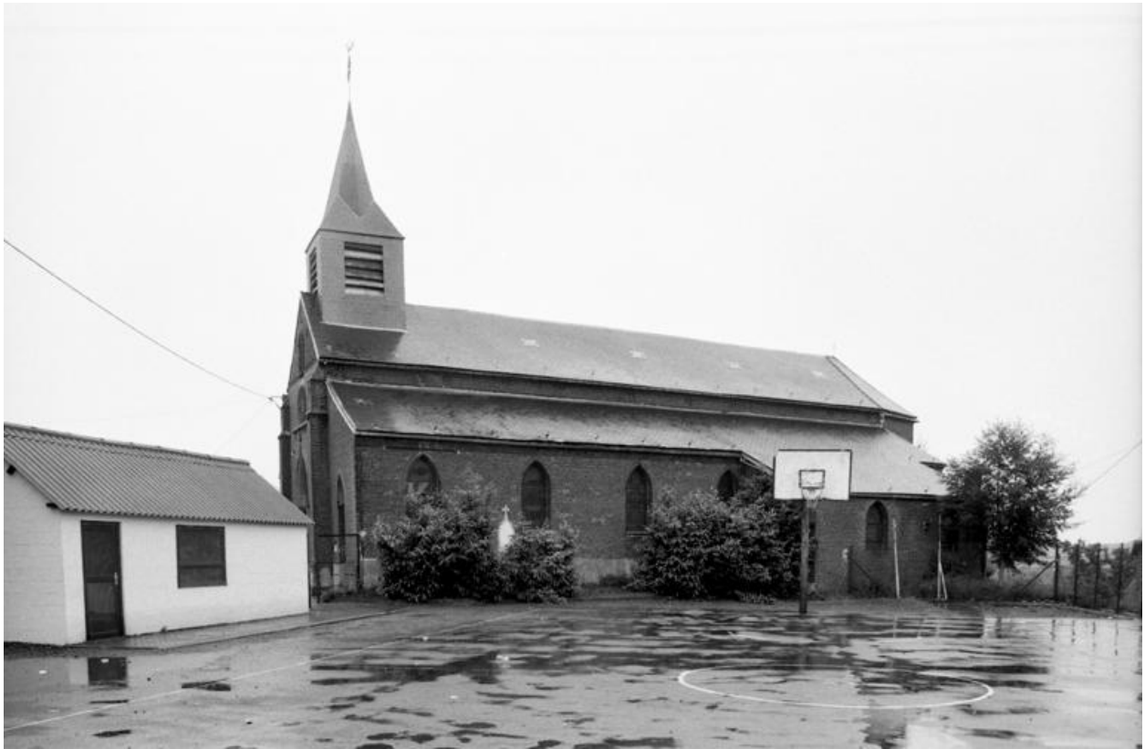
Vue d'ensemble de l'élévation sud.
