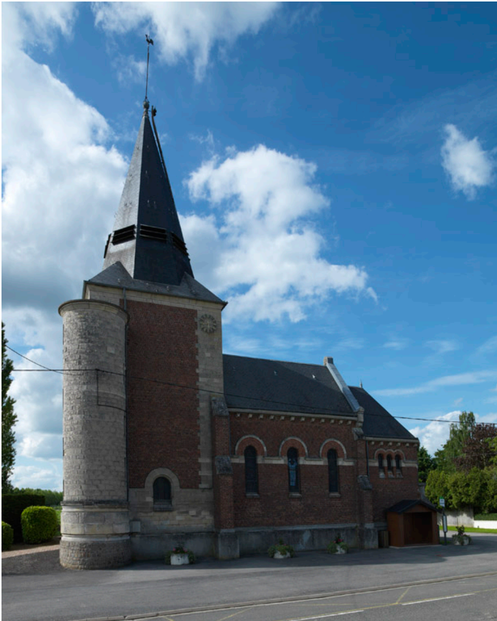
Vue générale depuis le sud.
