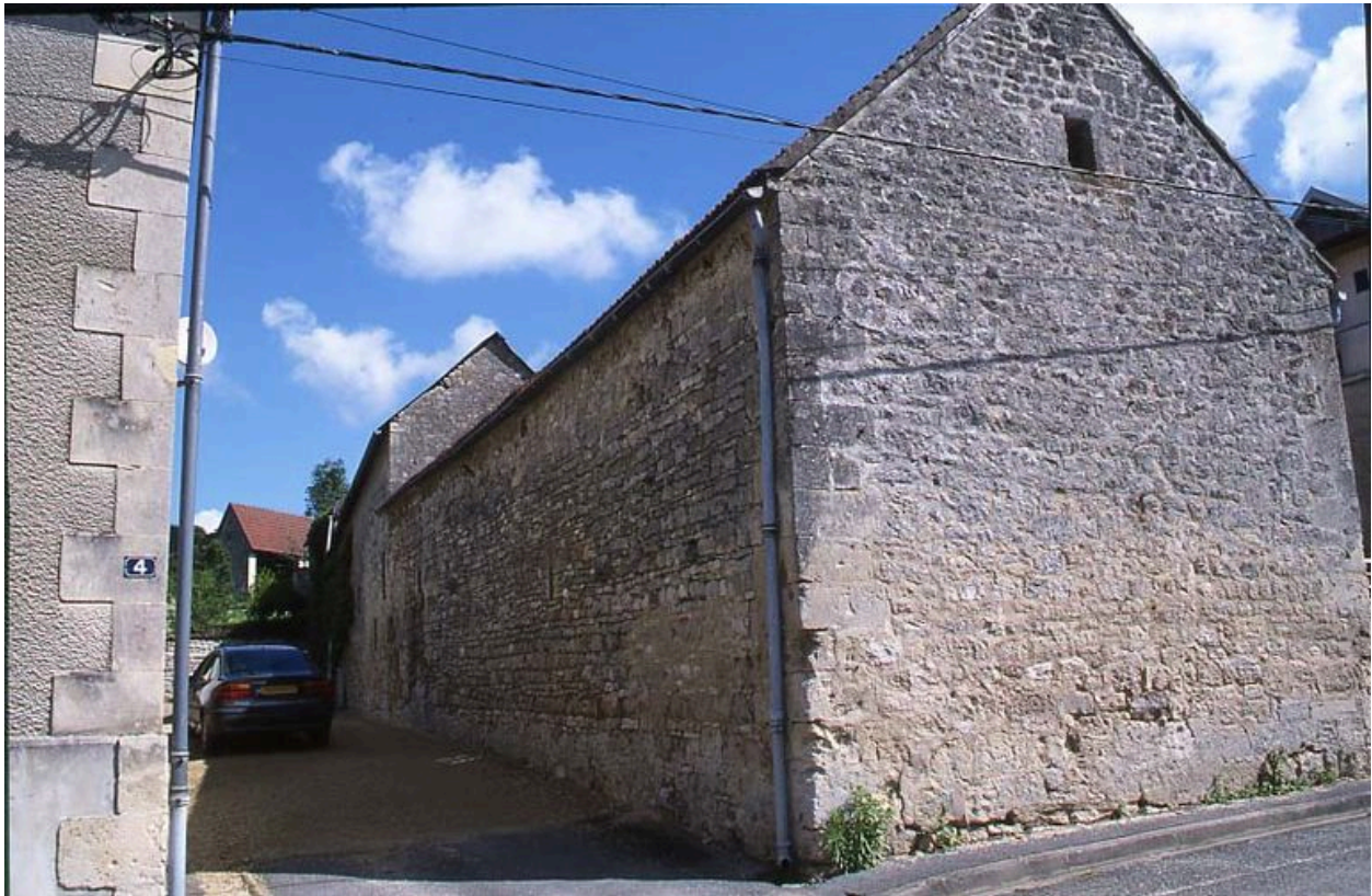
Vue latérale de la grange.
