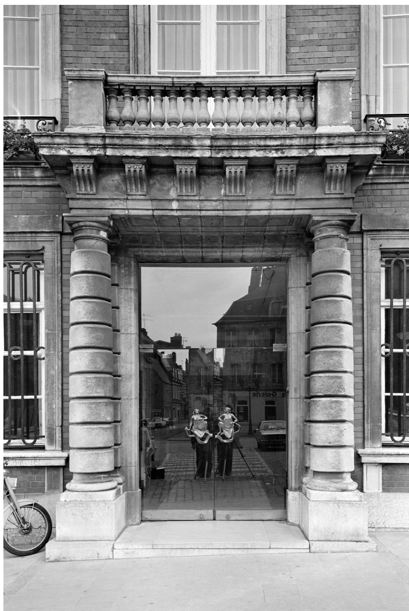
Porte d'entrée principale : détail.
