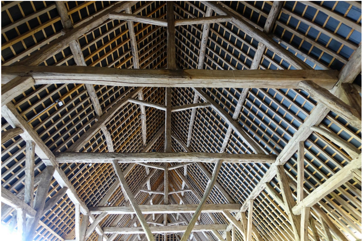
Charpente de l'ancienne grange et pressoir.
