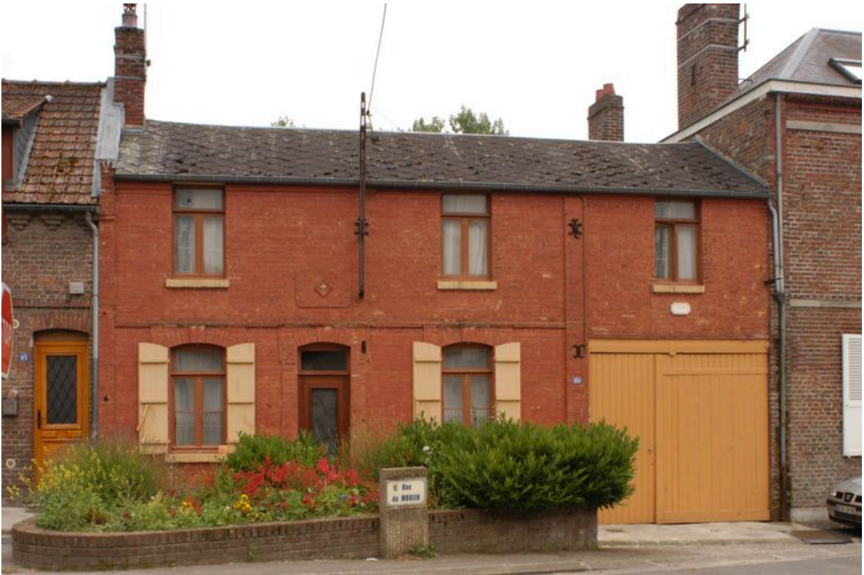
Vue de situation, maison au premier plan.
