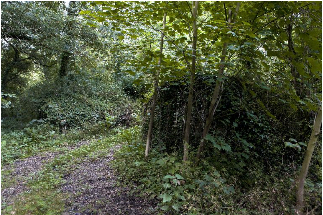
Casemate b) : Pignon de l'abri sous la végétation
