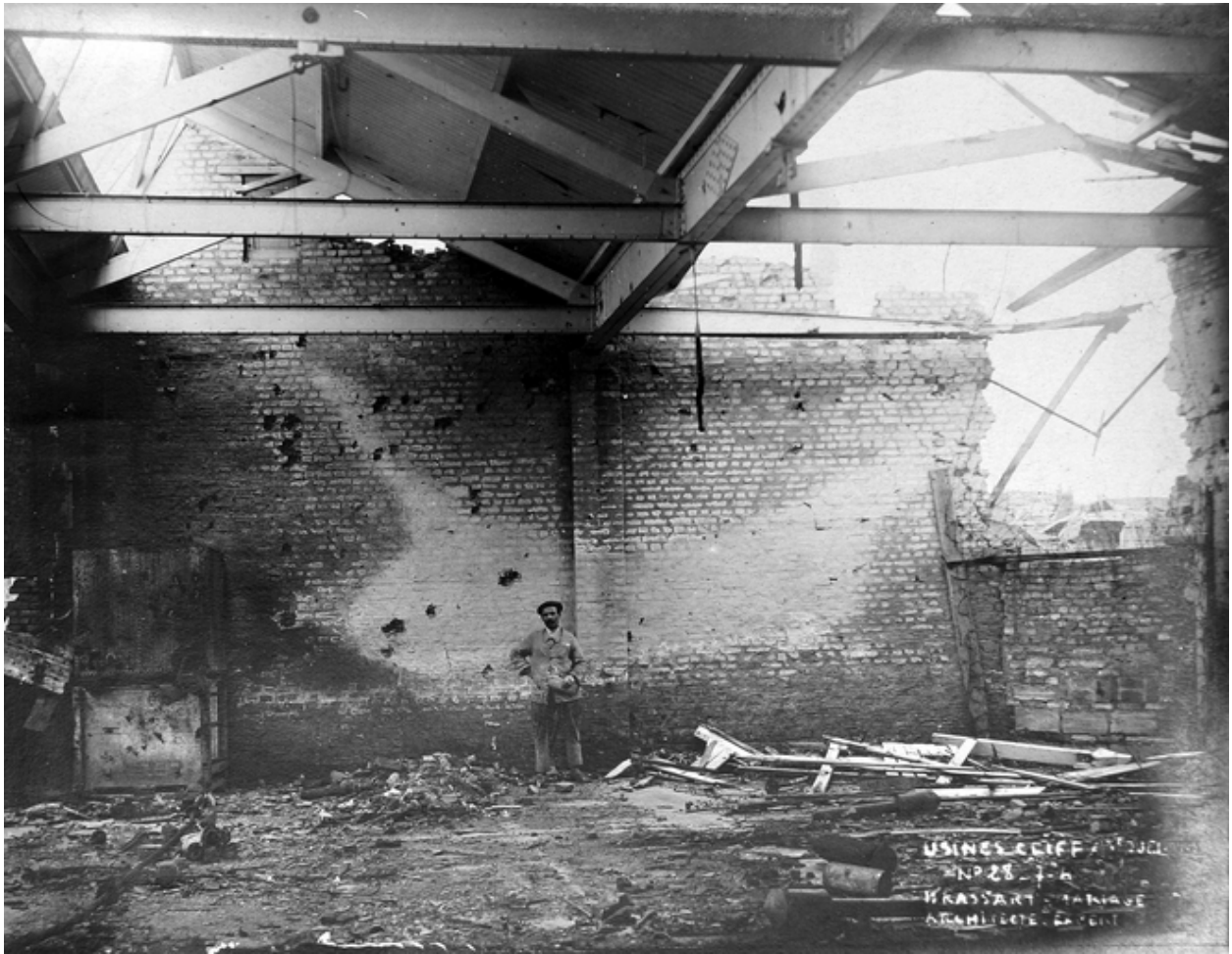
Vue intérieure de l'atelier de blanchiment, par Brassart-Mariage, mai 1919 (AD Aisne).
