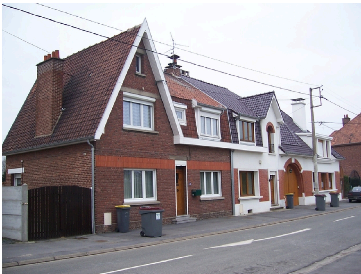
Maisons reconstruites, 55 et 59 rue des Soeurs-Liesse.
