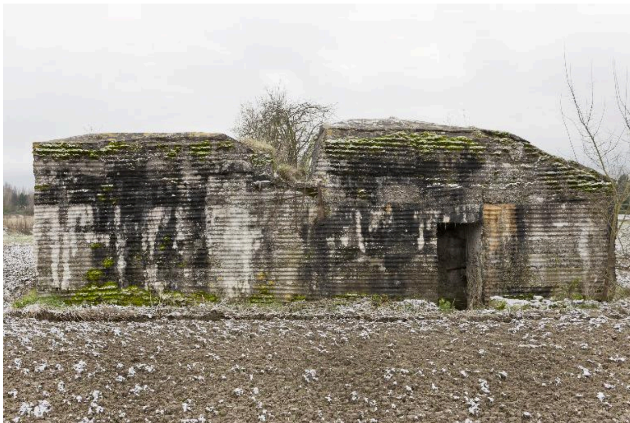
Entrée sur l'élévation nord-est.
