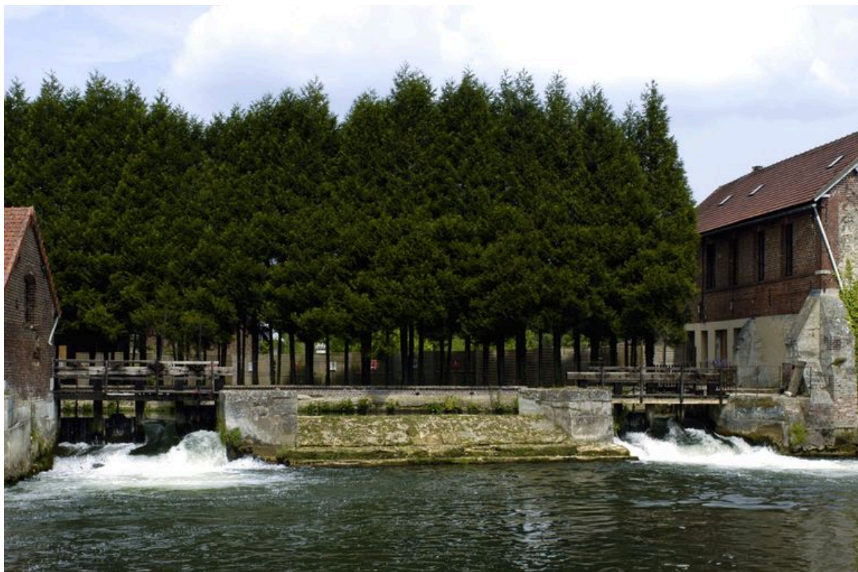
Le déversoir et les vannes de décharge.
