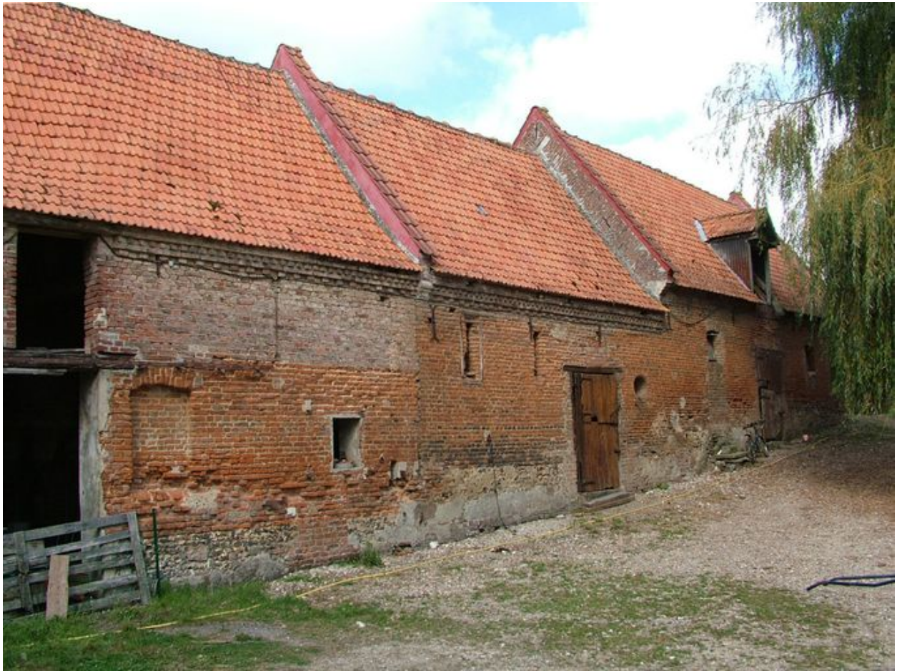
Vue des bâtiments d'exploitation bordant la cour à l'ouest.
