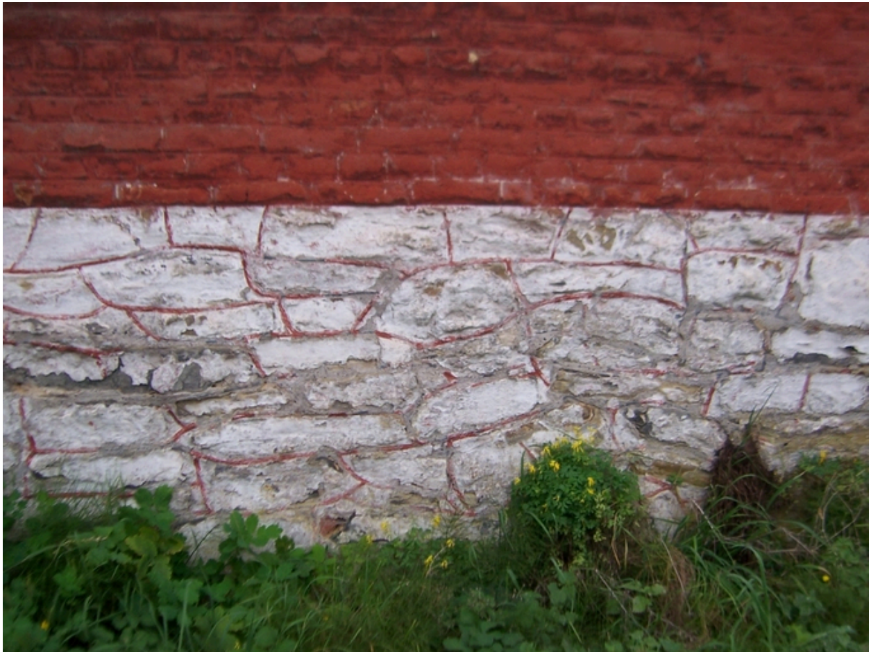
Détail du mur pignon sur rue : le soubassement en moellon de calcaire carbonifère (badigeonné de chaux).
