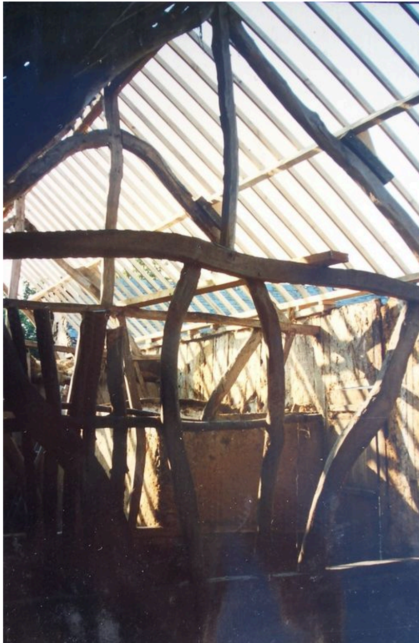
Vue de la charpente des étables.
