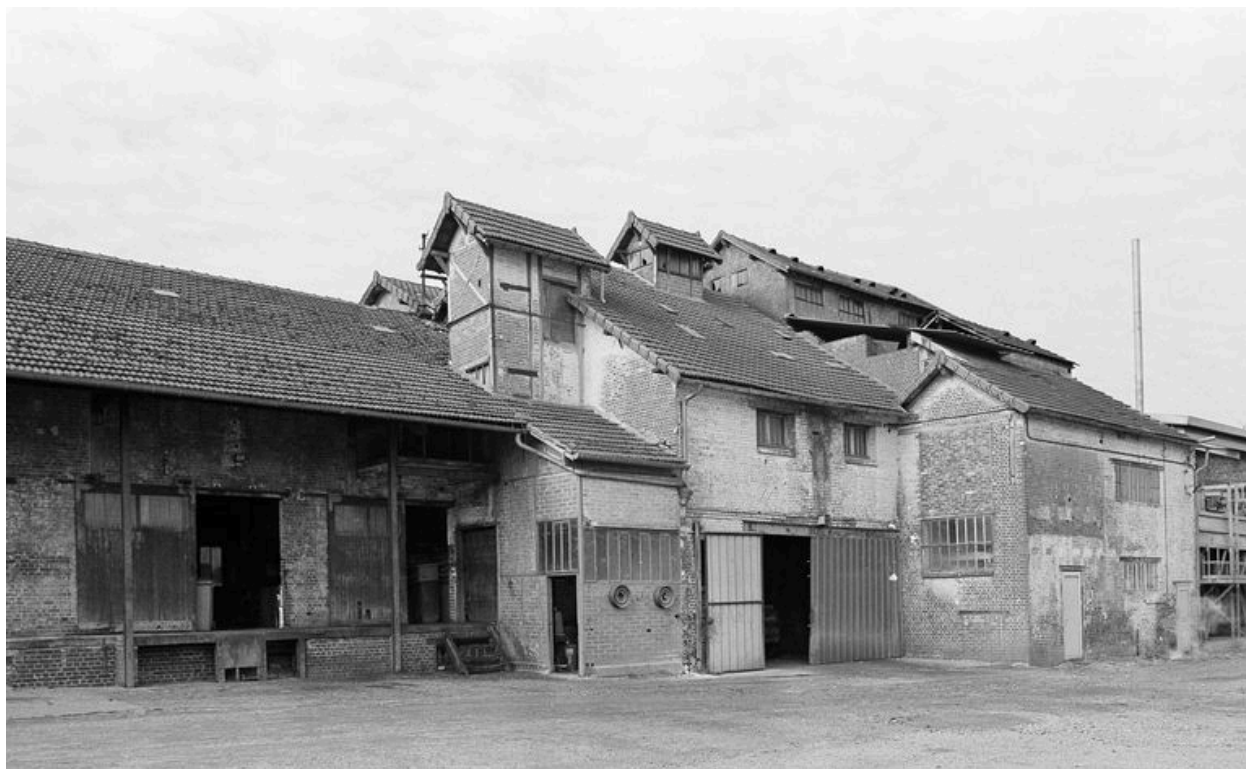
Atelier de fabrication : flanc est.
