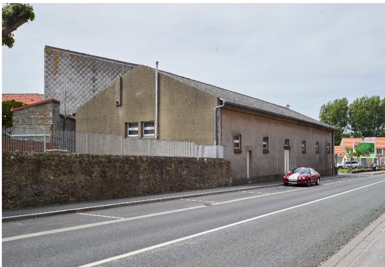
Élévation générale l'église.
