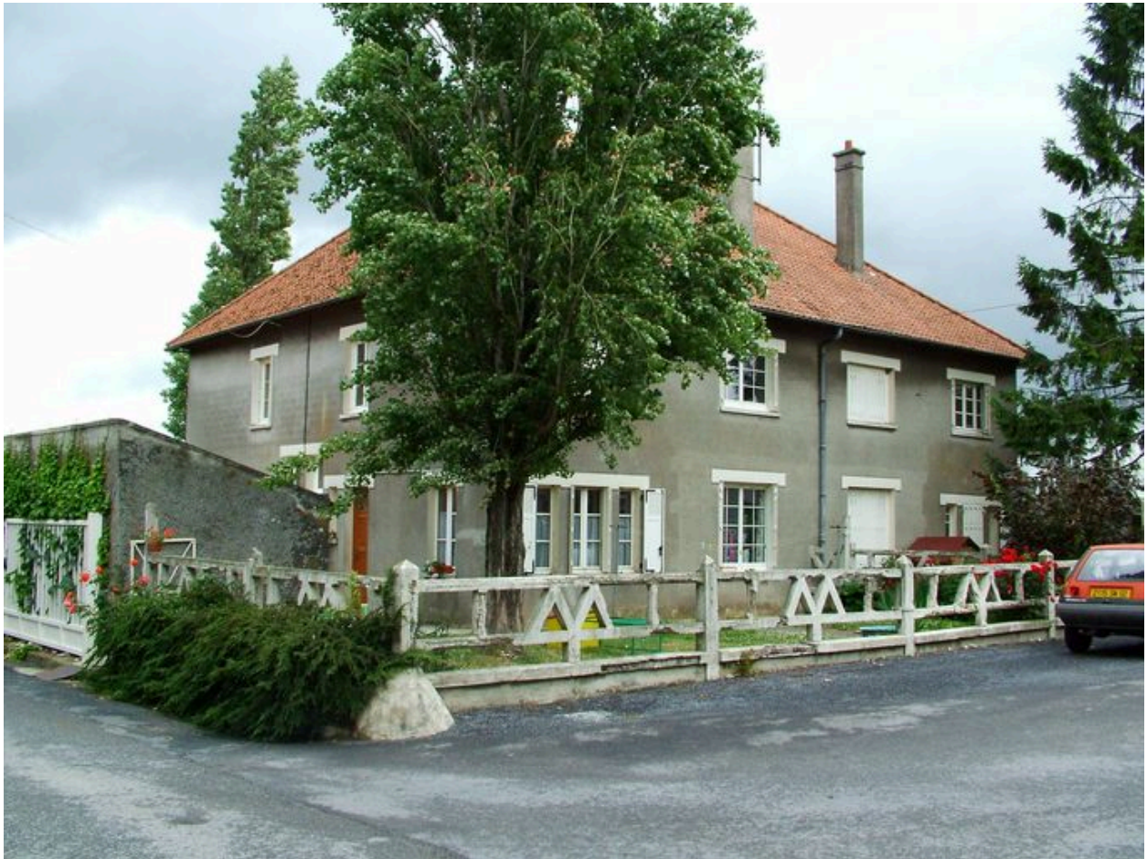
Vue d'une maison ouvrière collective.
