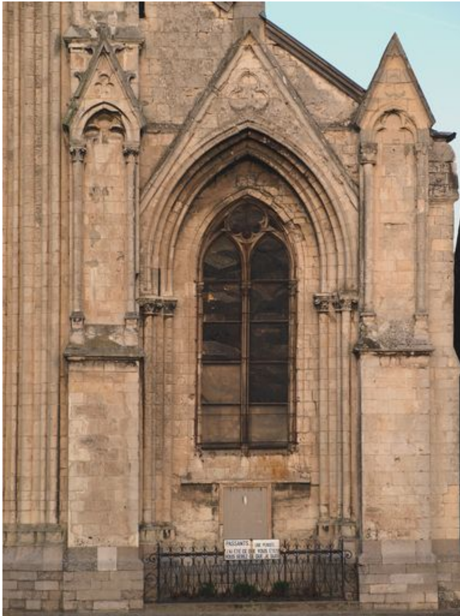
Baie occidentale du bas-côté sud
