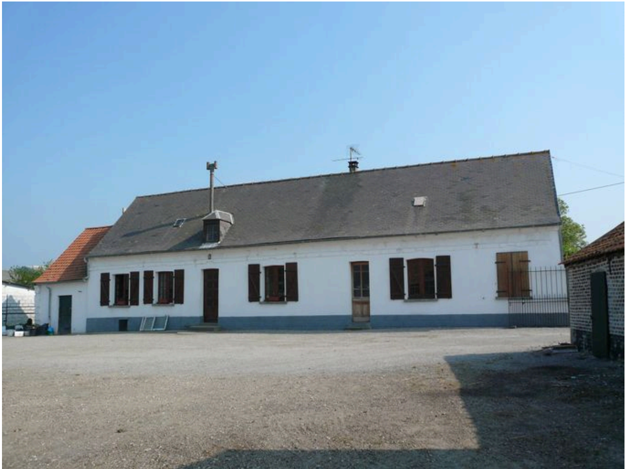
Vue du logis et de la laiterie à l'est.
