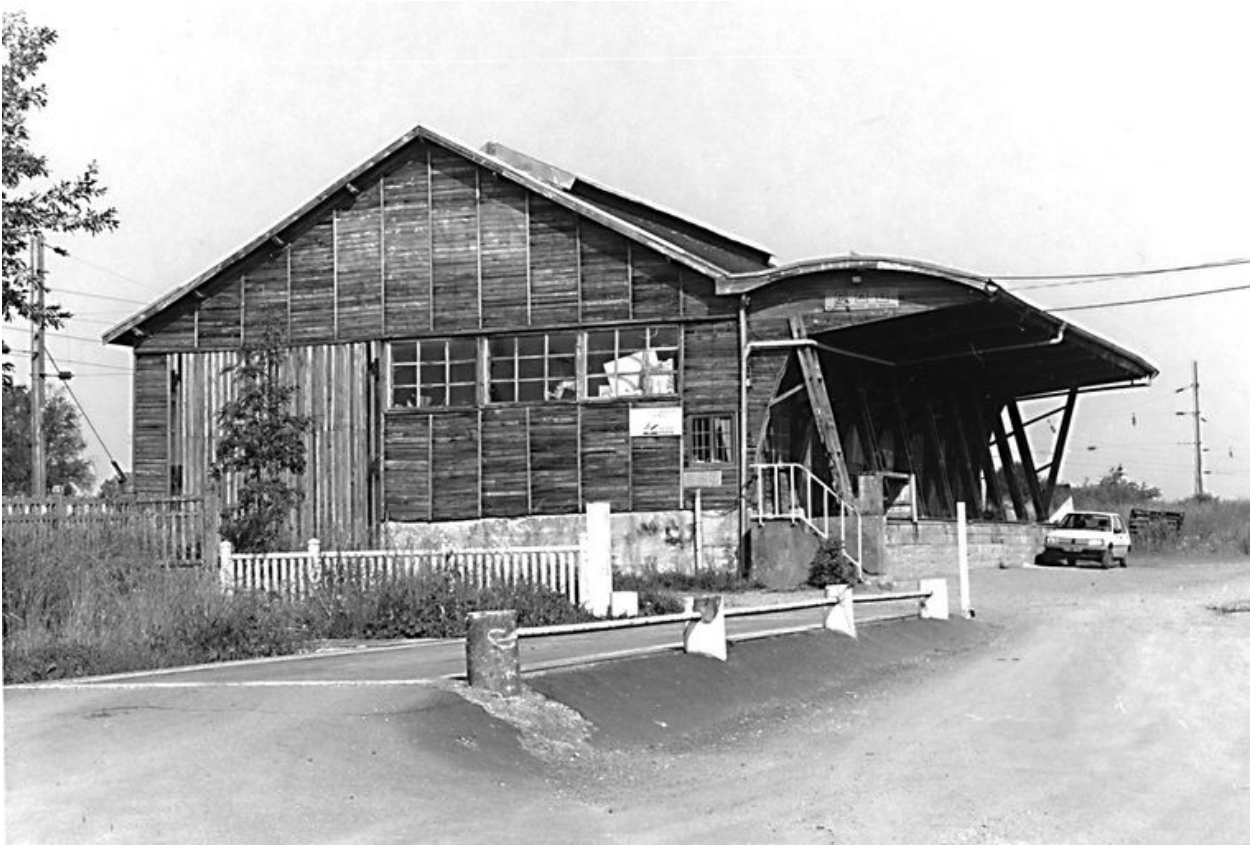
Entrepôt de marchandises.
