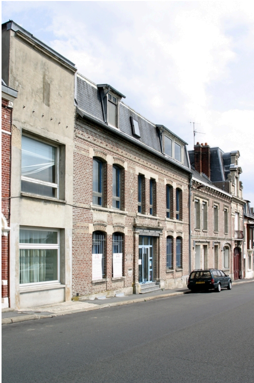
Façades antérieures, rue Voltaire.
