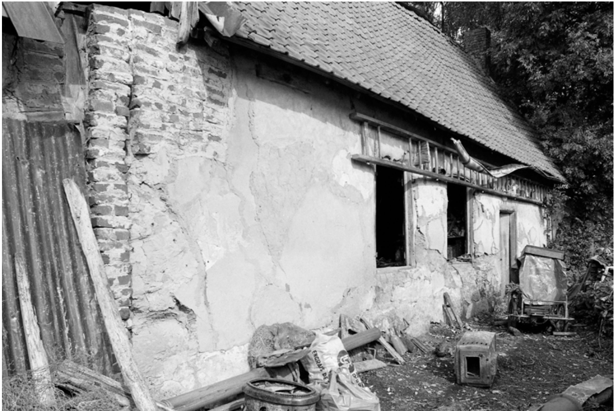
Vue actuelle de la façade du logis en torchis.
