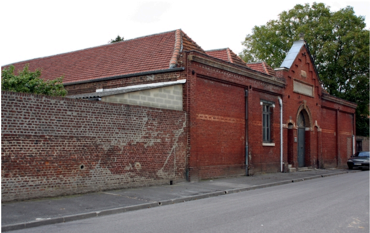
Les ateliers construits en 1907.
