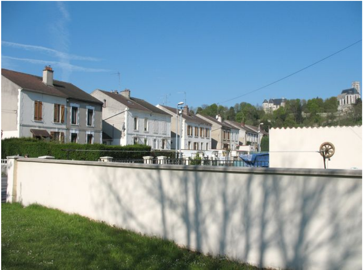
Barre de logements ouvriers de la cité Louis Blanc en maçonnerie.
