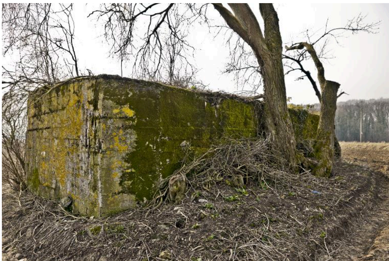
Vue de trois-quarts arrière, vers sud-ouest
