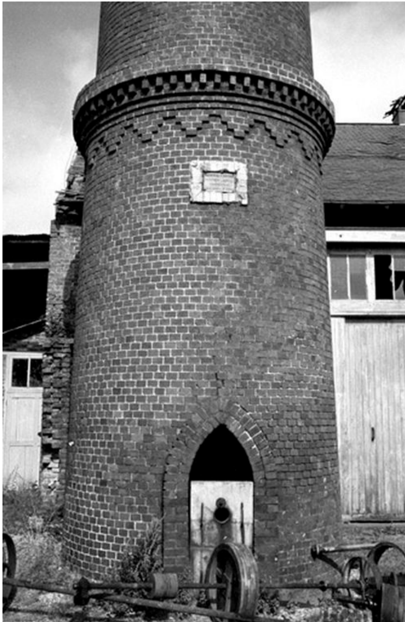
Cheminée d'usine, détail du socle.
