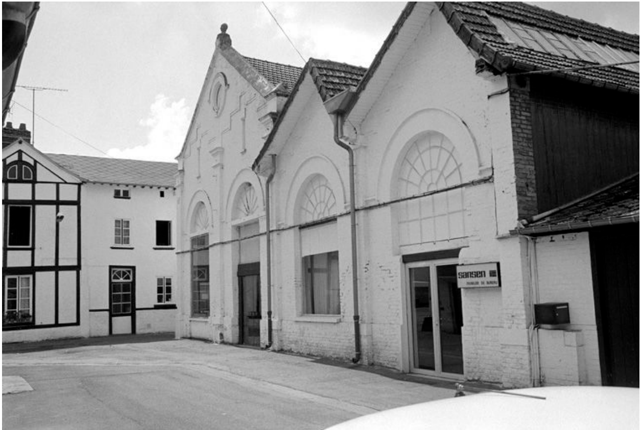
Ateliers de fabrication et chaufferie présumée, élévation est.
