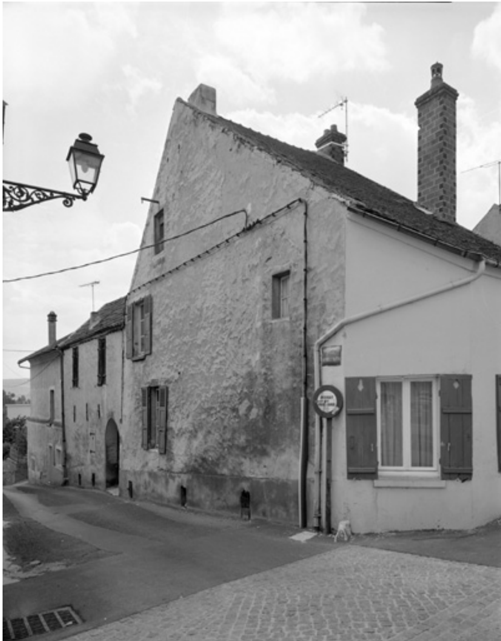
Vue de la façade sur la rue avec le passage voûté.
