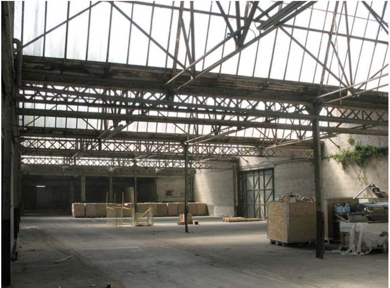
Atelier de montage couvert en sheds.
