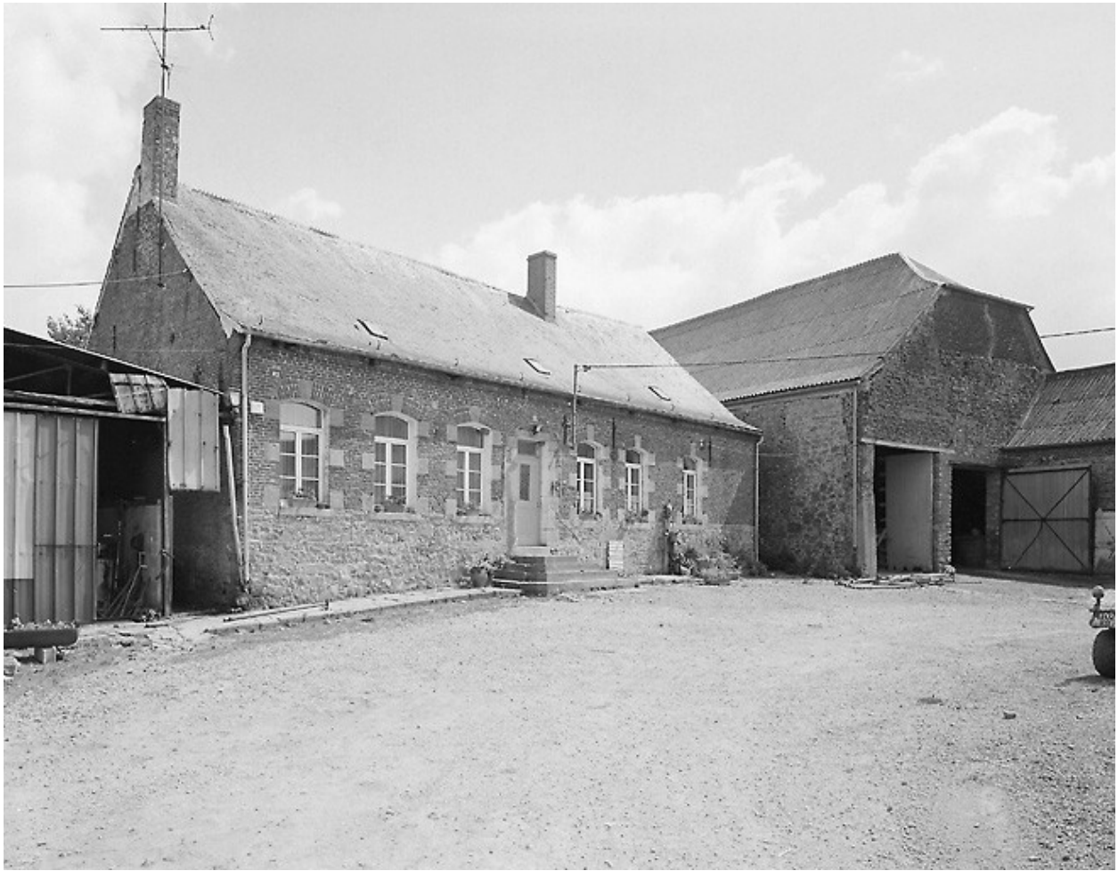
Vue du logis et de l'ouverture de la grange.
