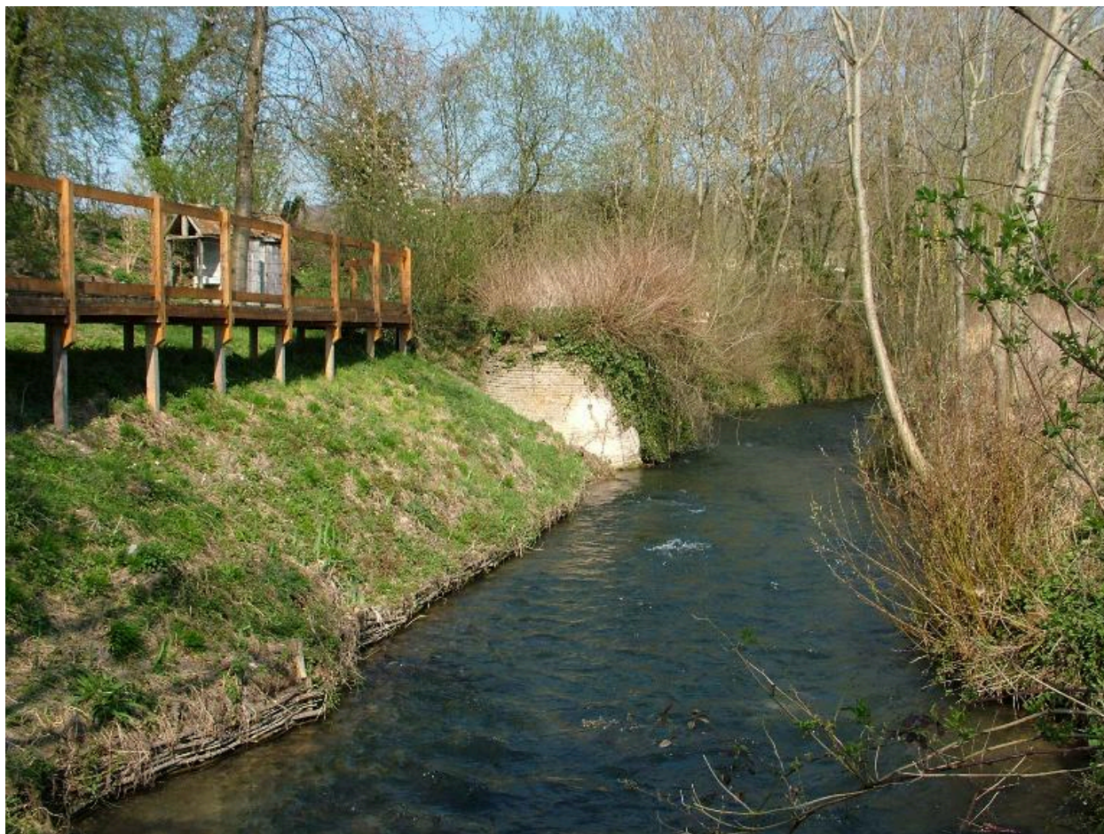
La Nièvre avec le massif de maçonnerie commandant la confluence avec l'ancien bief de dérivation.
