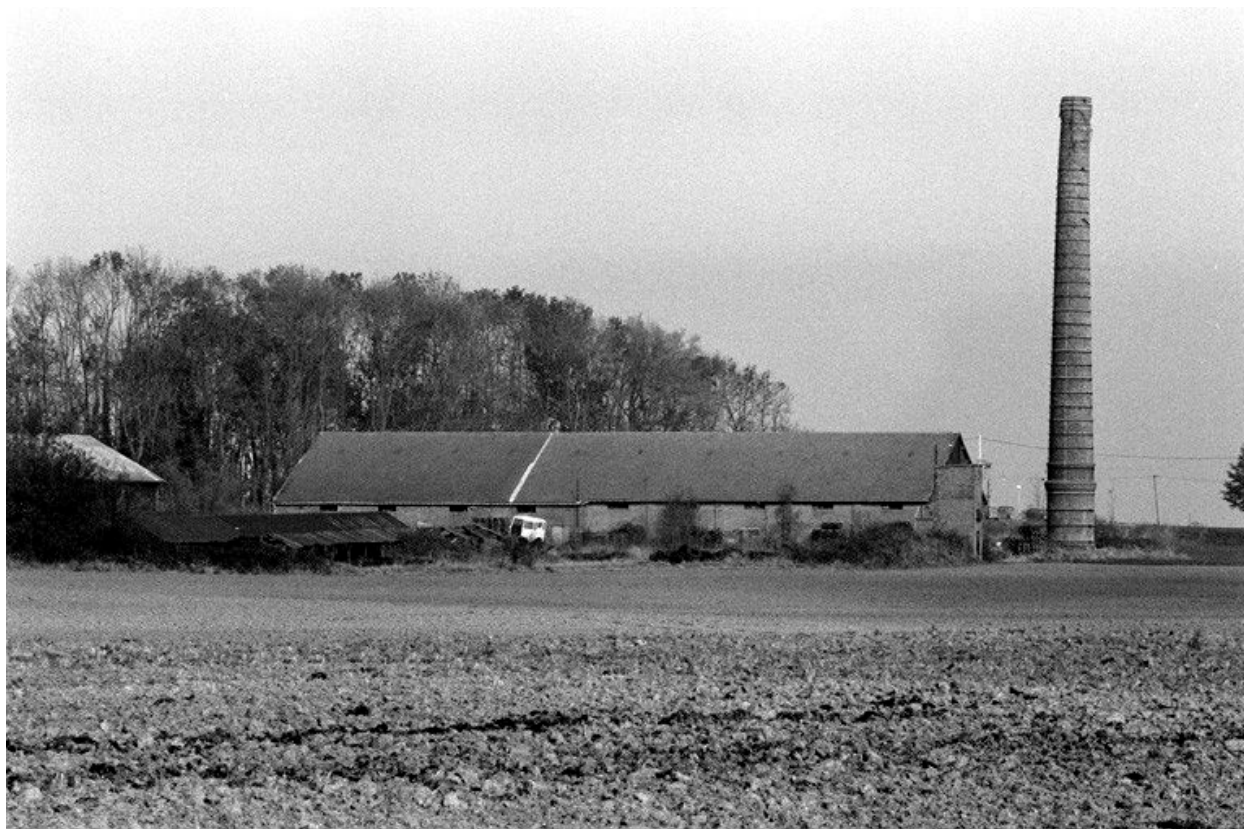
Four industriel et cheminée d'usine, vue flanc ouest.
