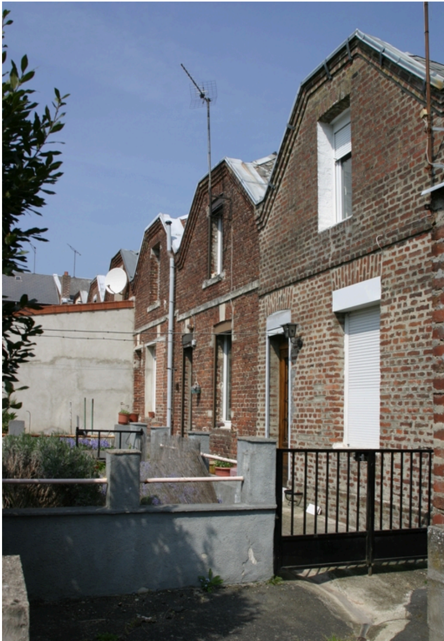
Premier groupe de six logements : façade postérieure.
